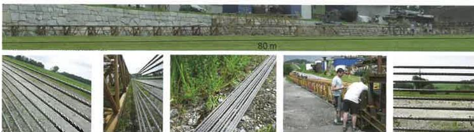
Abb. 2: Spannen eines 80 m langen Seilrechens „im Trockenen“
